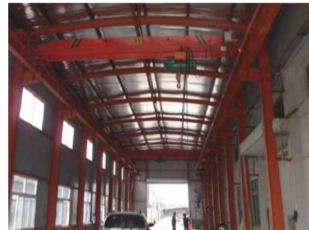
5月25日 屋根とクレーン完了
