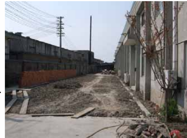
4月1日 基礎完了
